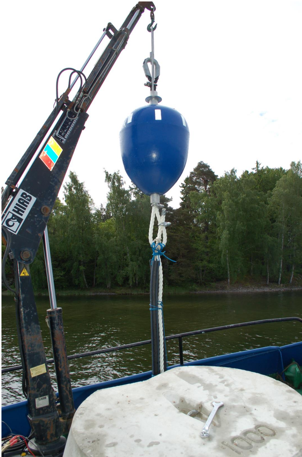
Bild 3 Iläggning av SXX-boj
