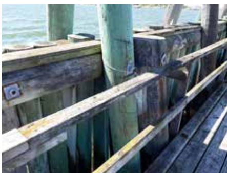
Vi mätte nere i vattnet intill vågbrytarens tryckimpregnerade trästolpar i Hinsholmskilen.
