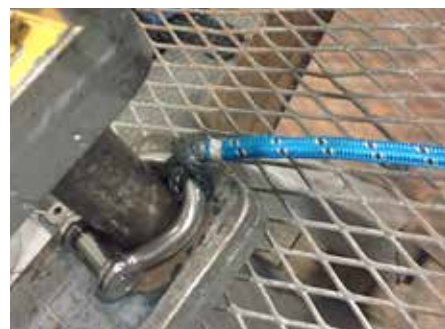
Dyneema-linor hade högre draghållfasthet än knopar och ögonsplitsar. Till och med schacklet deformerades.
