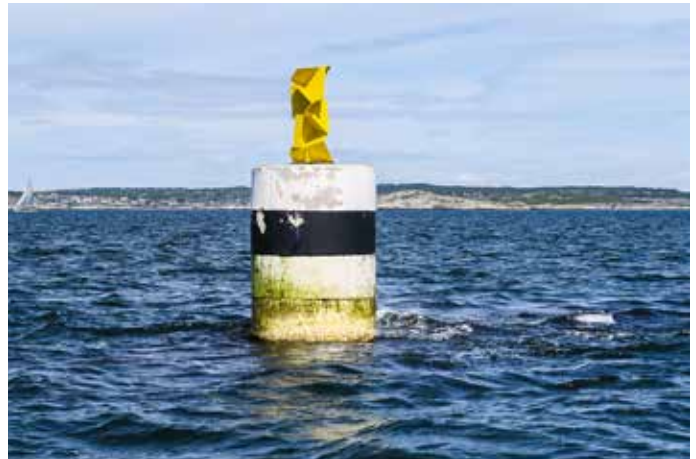
Mattsonsbadan på Hake fjord, före och efter renovering.
